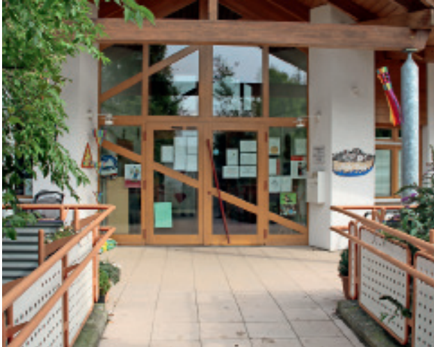
Abbildung 7: In Mischbauweise mit ungebundener Bettung erstellte Pflasterdecke.
