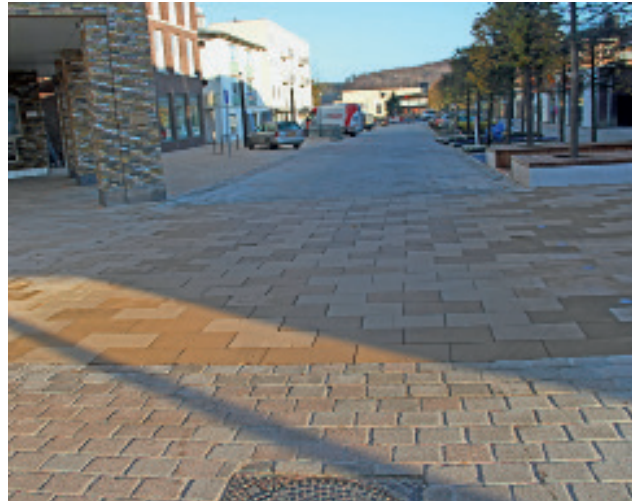
Abbildung 10: Ungebundener Fußgängerüberweg über eine in vollgebundener Bauweise ausgeführte Straße.
