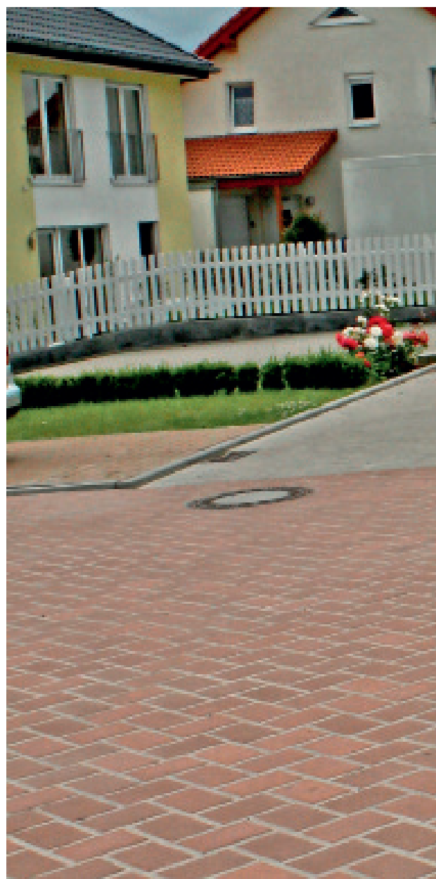
Abbildung 5: In vollgebundener Bauweise ausgeführte Anliegerstraße.
