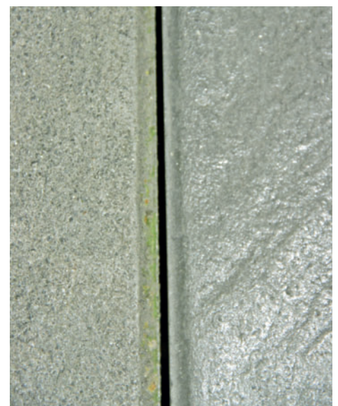
Abb. 16: Glanzverlust und Farbveränderung durch einen lösenden Angriff auf vergütete Produkte
