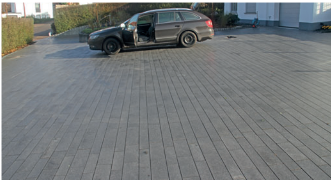
Abb. 1: Aufhellung vergüteter Betonplatten
