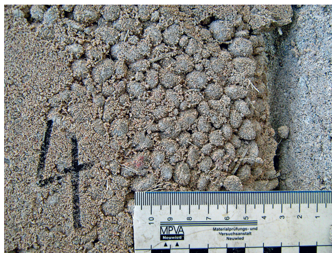
Abb. 3: Reduzierte Verdichtbarkeit des Bettungsmörtels aufgrund einer zu geringen Menge an Zementleim
