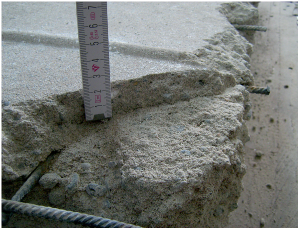
4 Entstehung von Trennschichten beim Einsatz von Bewehrung
