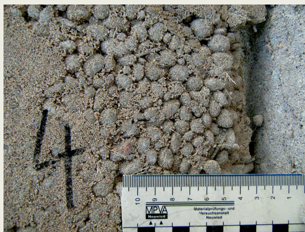
7 Nicht ausreichend verdichtete Unterseite des Bettungsmörtels aufgrund zu steifer Konsistenz
