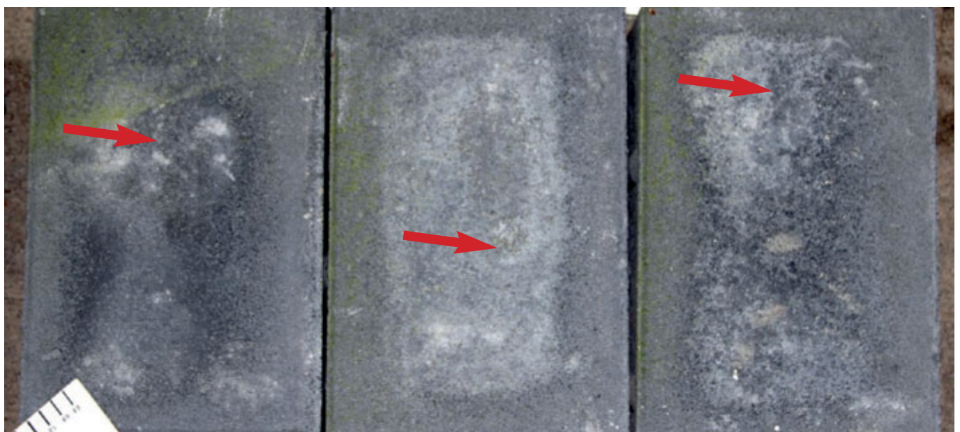
Bild 7: Betonpflastersteine mit starken (baustoffuntypischen) Ausblühungen
