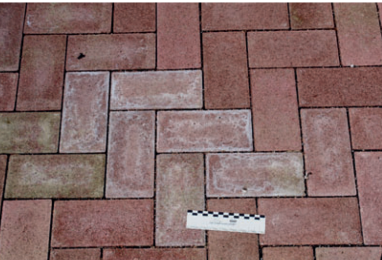
Bild 1: Betonpflastersteine mit signifikanten Ausblühungen
