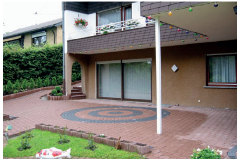
Bild 2: Betonpflastersteine mit signifikanten Ausblühungen
